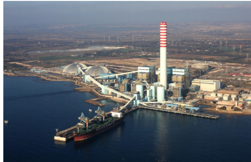
Vista panorámica de la central de Torrevaldaliga Nord
